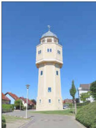
Die Baumaßnahmen umfassten den Rück- und Neuaufbau des Fußbodens der Aussichtsplattform sowie die komplette Überarbeitung der Putzflächen im Außenbereich.
