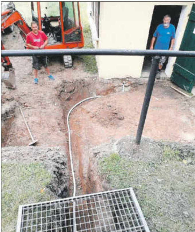
Mitglieder des Feuerwehrvereins erbrachten 2019 Eigenleistungen bei der Erneuerung der Elektroanlage.
