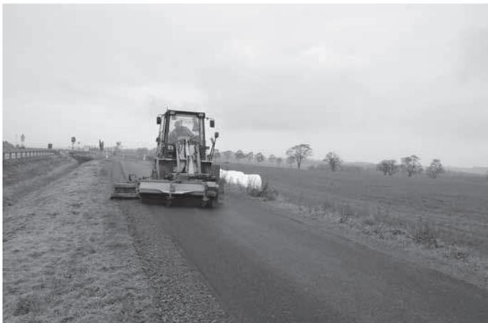
Der bereits zur Verfügung stehende ungebundene Straßenunterbau wurde in Teilbereichen zur Gewährleistung einer ausreichenden Tragfähigkeit verstärkt und mit einer ca. 3m breiten und 10 cm starken Asphalttragdeckschicht und entsprechenden Banketten ausgebaut.
